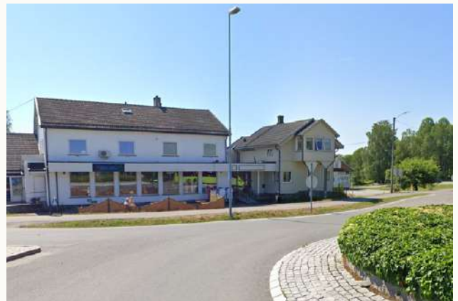
2 Vest for skolen ligger tre eldre bygg som i dag brukes til næring. Disse er SEFRAK-registrerte.
